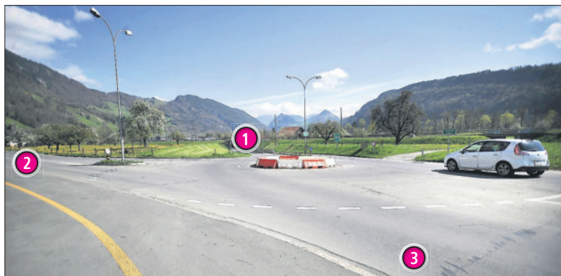
Der provisorische Kreisel Feld bei der A-8-Ausfahrt in Alpnachstad. Bild Corinne Glanzmann
