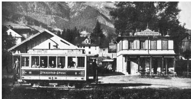
Das Tram Stansstad-Stans im Vordergrund, dahinter das ehemalige Depot.
